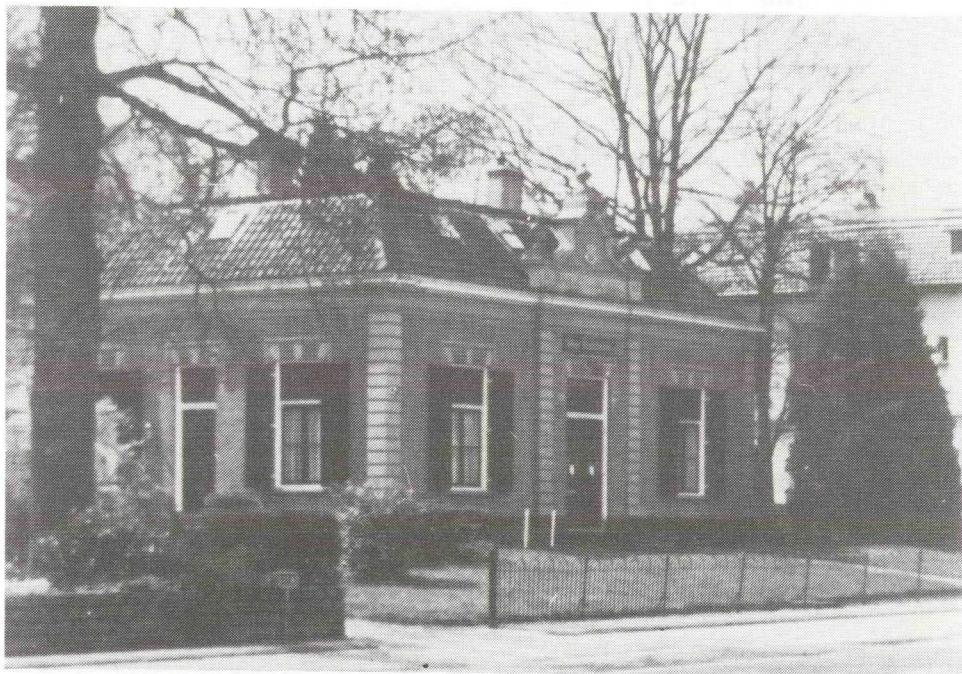
Het Anna Paulownahuis, gebouwd in 1893, ter vervanging van een vervallen schoolgebouw.
